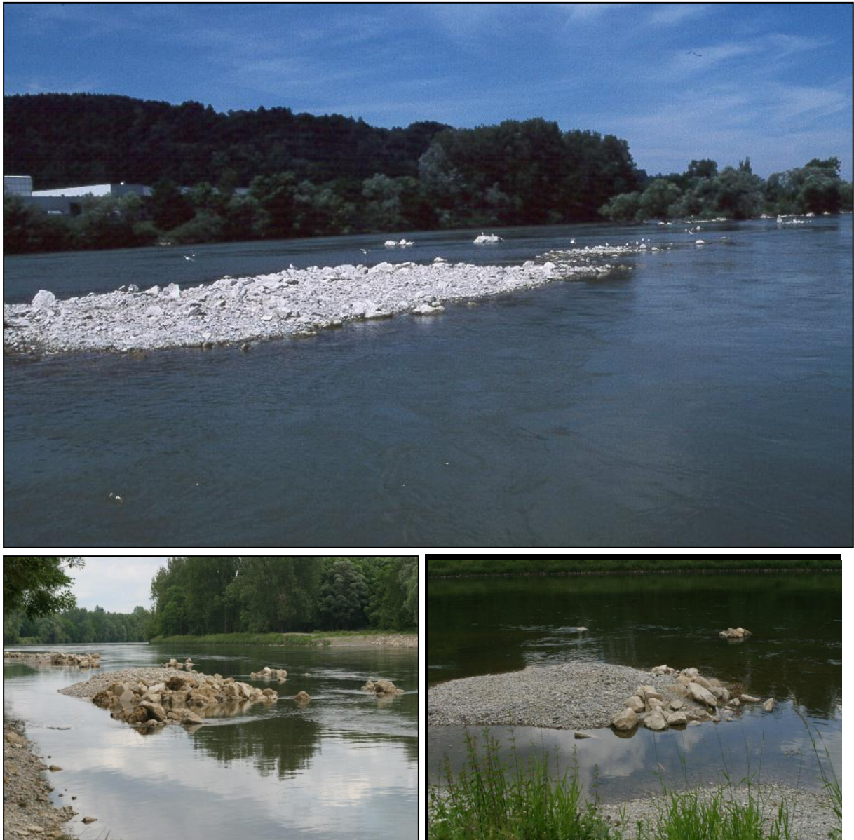
Abb. 11: Bild oben: 1998 erstellte Kiesinsel in der Donau bei Vilshofen; Bilder unten: neue kleine Kiesinseln in der Donau zwischen Vohburg und Neustadt mit heterogener Strukturierung, funktionsfähigen Kieslaichplätzen und Jungfischhabitaten (BNGF 2009a, 2010a, 2011a, Donau bei Vohburg).
