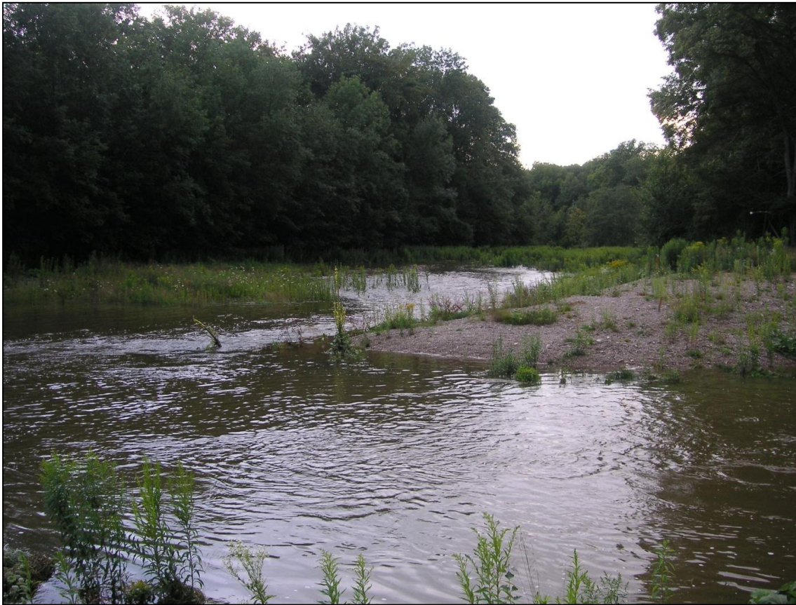
Abb. 24: Praxisbeispiel: Umgehungsgewässer/Aue-Fließgewässer an der Donaustufe Bergheim (Inbetriebnahme 2010): Kieslaichflächen und Wechselwasserbereiche mit kiesigen Sukzessionsflächen, heterogenem Strömungsregime.
