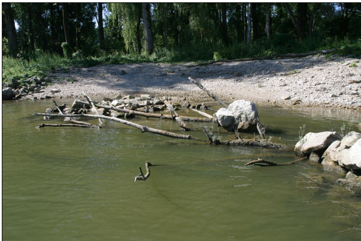
Abb. 13: Neu erstellter (2007) kleinräumiger Uferrückbau mit Hakenbuhne, Totholz-Blocksteinelementen und flach geneigter Uferböschung (Jungfischhabitate, Rückzugsbereiche bei Hochwasser); Donau Bereich Vilshofen, Bürgerfeld.
