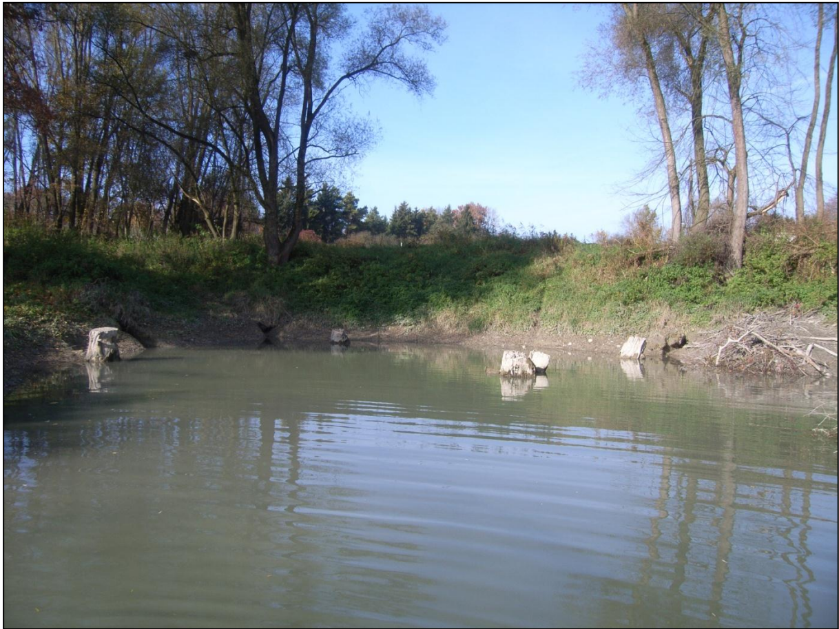
Abb. 14: Neu erstellter (2008/09) großräumiger Uferrückbau (Einbuchtung) mit Wurzelstöcken/Totholz und Biberbauten. Donau Bereich Vohburg-Neustadt. Funktionsfähigkeit als Jungfischhabitat für indifferente Arten, Hochwasser- und Wintereinstand nachgewiesen (BNGF 2009a, 2010a, 2011a).
