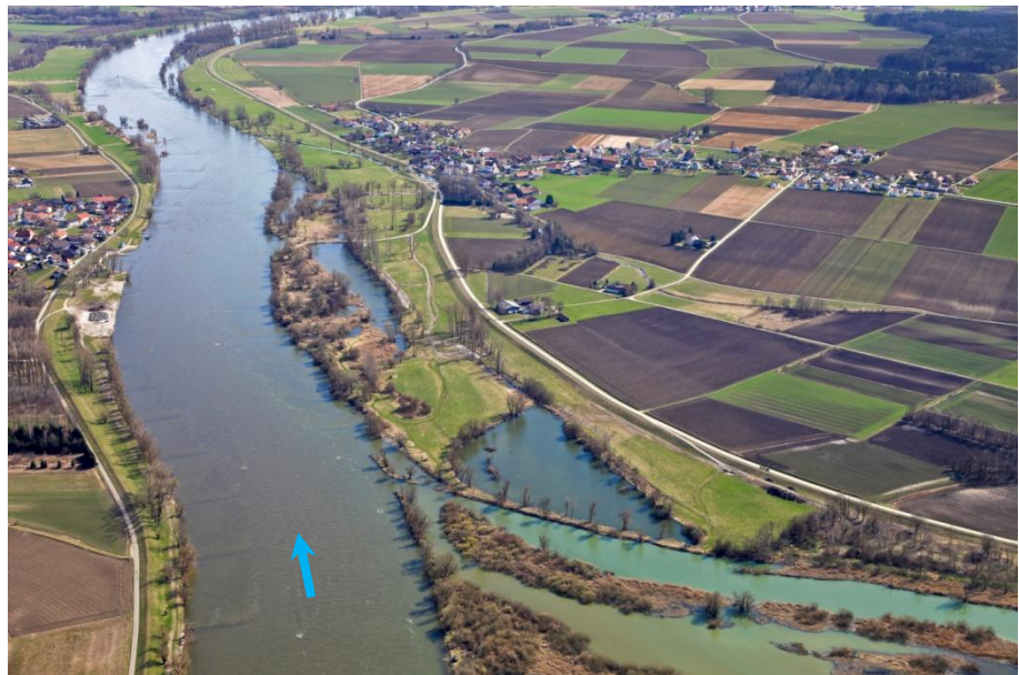
Abb. 2 Das Projektgebiet erstreckt sich zwischen der Donau und dem orographisch rechten Hochwasserschutzdamm (sichtbar als Straße)
