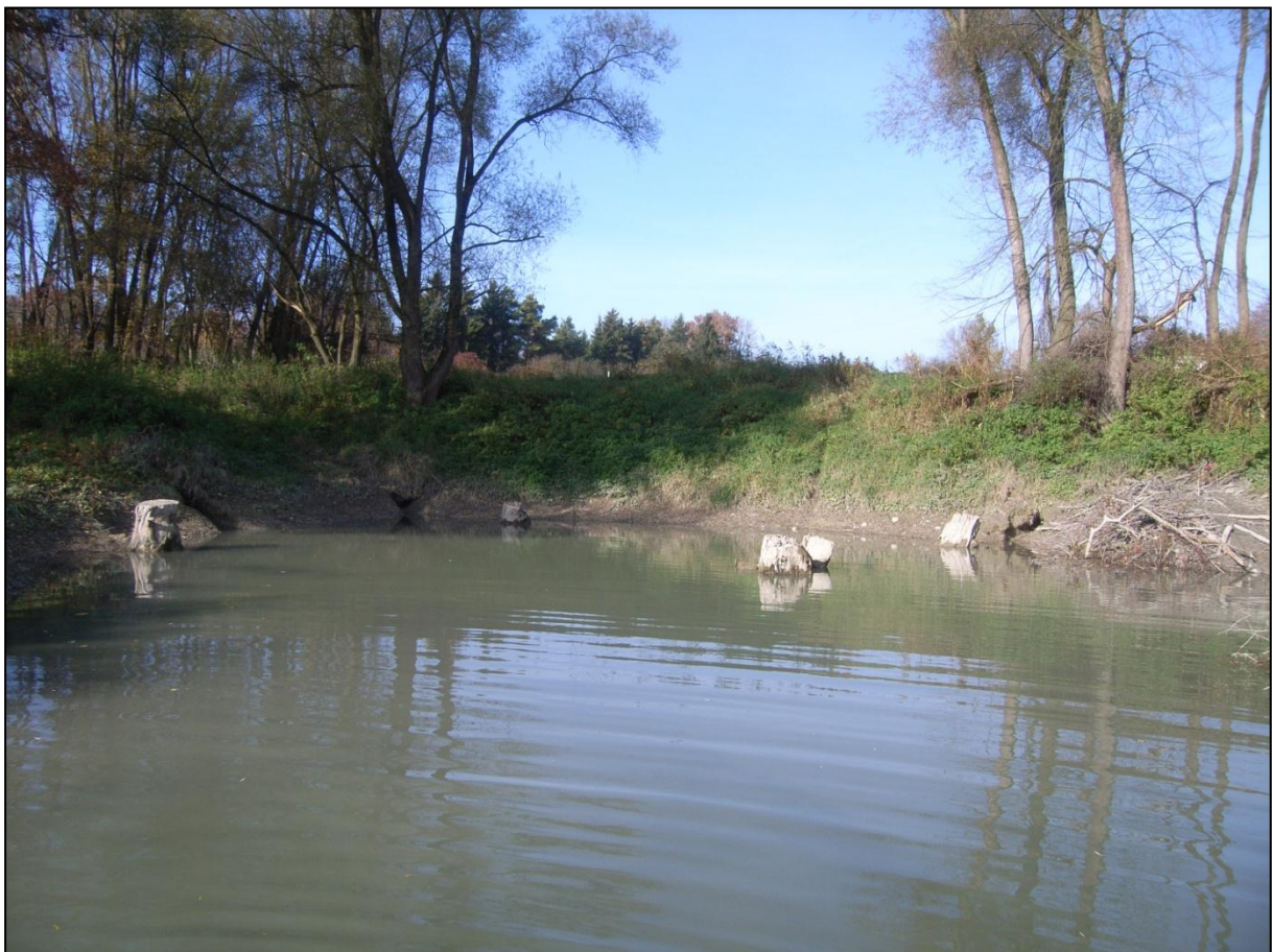
Abb. 13: Neu erstellter (2008/09) großräumiger Uferrückbau (Einbuchtung) mit Wurzelstöcken/Totholz und Biberbauten. Donau Bereich Vohburg-Neustadt. Funktionsfähigkeit als Jungfischhabitat für indifferente Arten, Hochwasser- und Wintereinstand nachgewiesen (BNGF 2009a, 2010a, 2011a).
