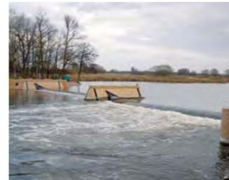
Angepasst werden bei Variante C 2,80 noch 91 Buhnen und 9 bestehende Parallelwerke, neu gebaut werden 59 Buhnen und 6 Parallelwerke.
