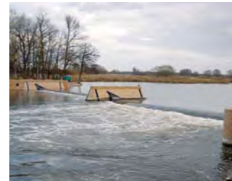
Schlauchwehr bei Bahnitz
