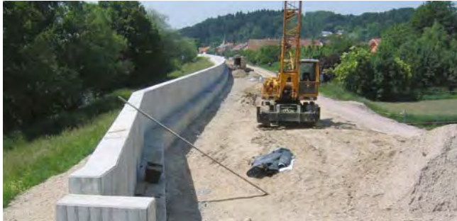
Neubau eines Deiches
